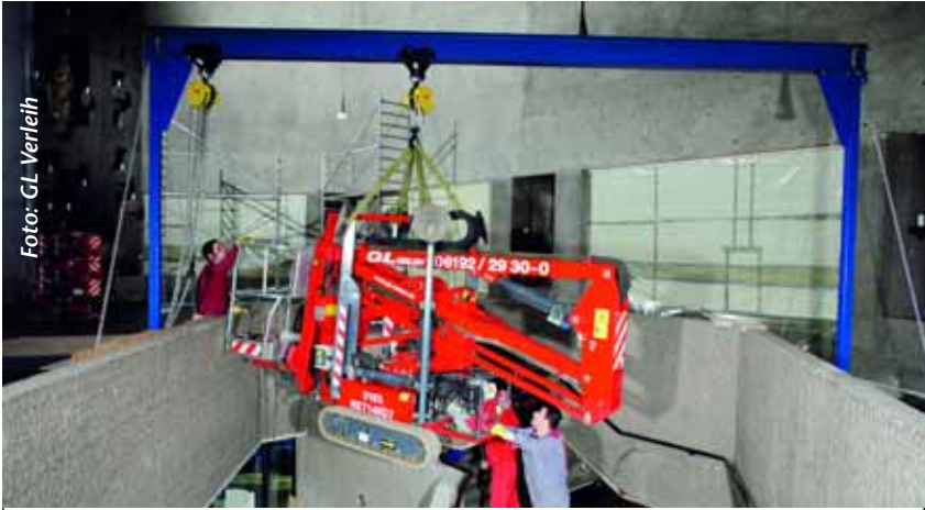
Kran hilft Bühne: Für einen anspruchsvollen Einsatz in einer Kirche setzte GL Verleih beim Höhenzugang auf insgesamt fünf Hinowa-Raupenbühnen.
