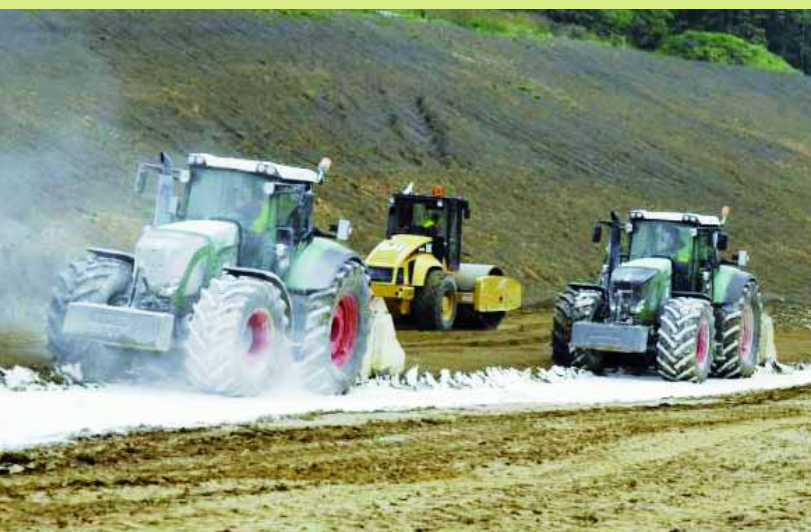
AUF DIESER GROSSBAUSTELLE haben Schlepper die Nase vorn.
