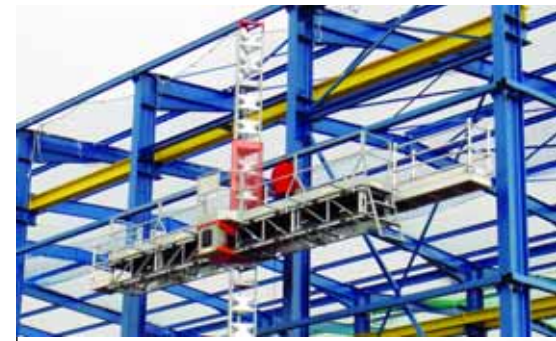
Arbeitsplattform: Eine Mastkletterbühne von Fraco übernahm die Montage der Profiltafeln.
