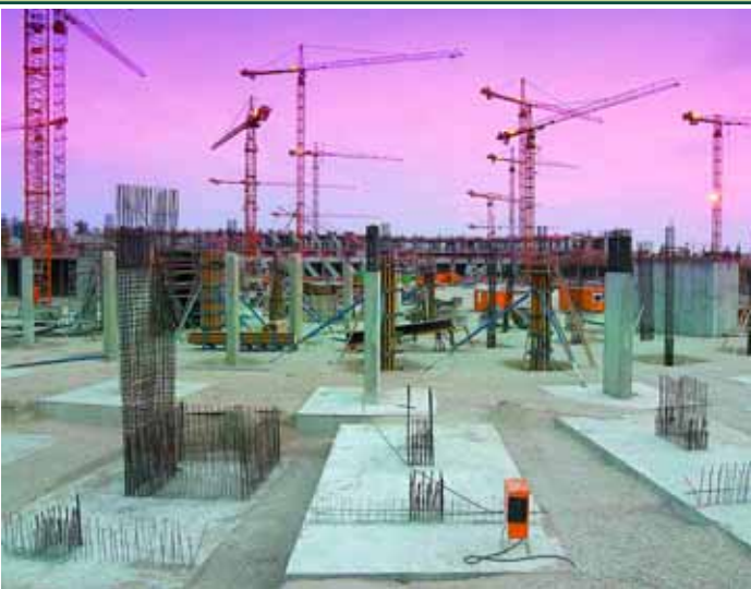
LÄNGST GESCHICHTE: Auch die Fußballarena in München entstand unter den Auslegern einer Armada von unten- und obendrehenden Turmkranen.
