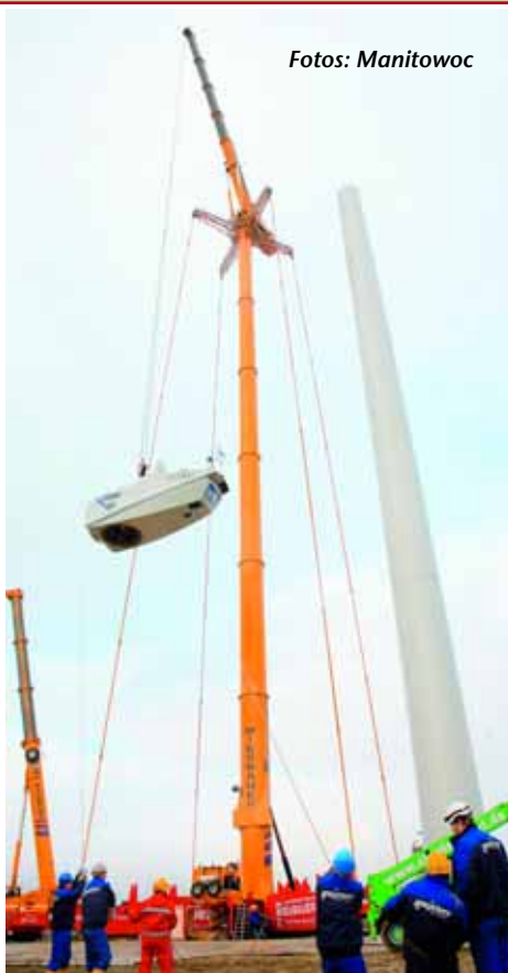
Vor einem Jahr: Der erste Serien-GTK bei der WKA-Montage.
