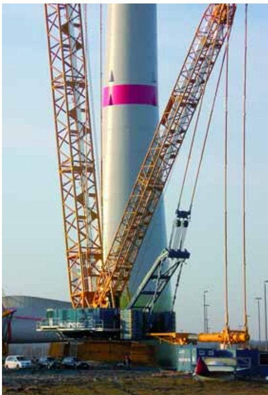
VORARBEITEN IM MORGENGRAUEN: Die neue CC 9800-1 wird in Hamburg bei der WKA-Montage von zwei kleineren Raupen unterstützt.
