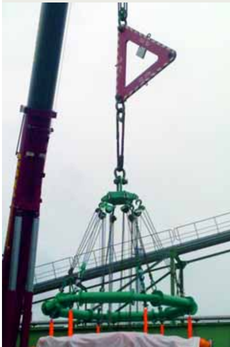
Kombiniertes Anschlagmittel: Ein sechseckiges Lastaufnahmemittel mit Triangel. (Foto: Lenzen)
