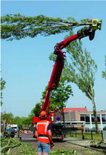
Starkes Team: Die Firma Weijtmans hat einen MKG-Montagekran mit einem Manipulator kombiniert.
