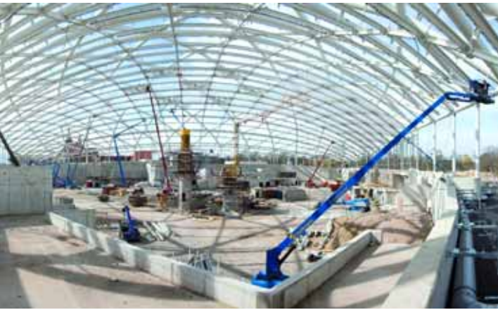
Hoch hinaus: Beim Bau im Leipziger Zoo kam die neue Bühnentechnik von Gardemann zum Einsatz. (Foto: Gardemann)
