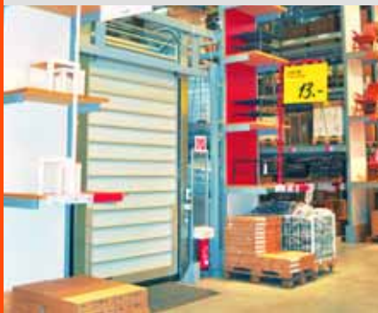
Kunden- und kindersicher: Die Schnell-Lauftore von Efaflex schließen das Fördersystem zum Verkaufsraum hin ab.
