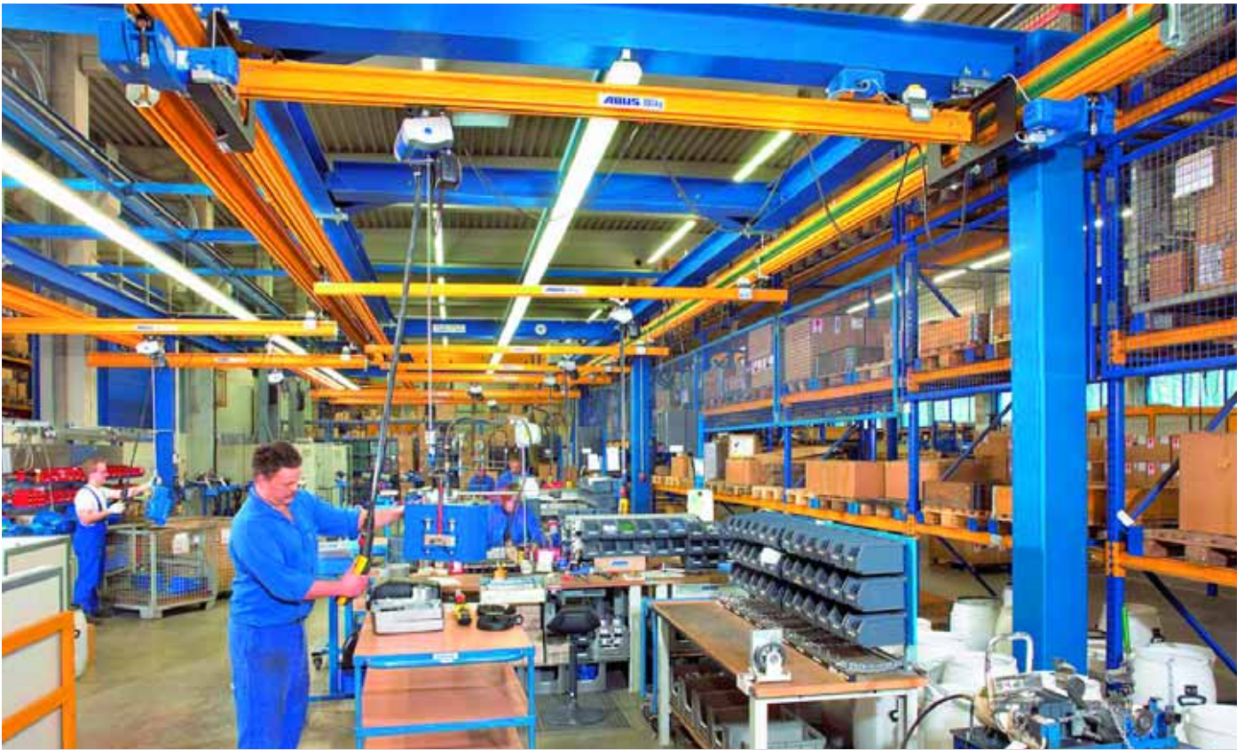
Wertvolle Zentimeter gewinnen: Der Kranträger des aufgebockten HB-Krans hängt zwischen den Kranbahnen (im Vergleich hierzu der herkömmliche EHB-Kran im Hintergrund).
